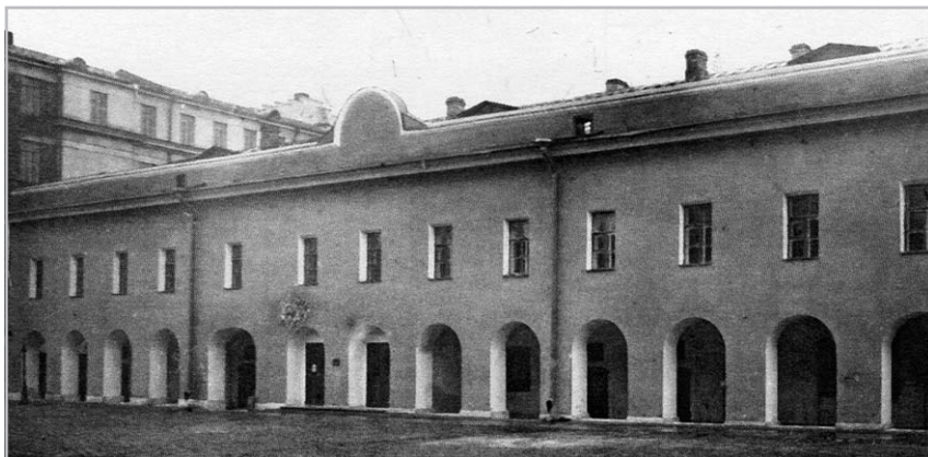
Здание бывшего Таможенного архива, в котором в 1922–1927 гг. находился Пушкинский Дом
