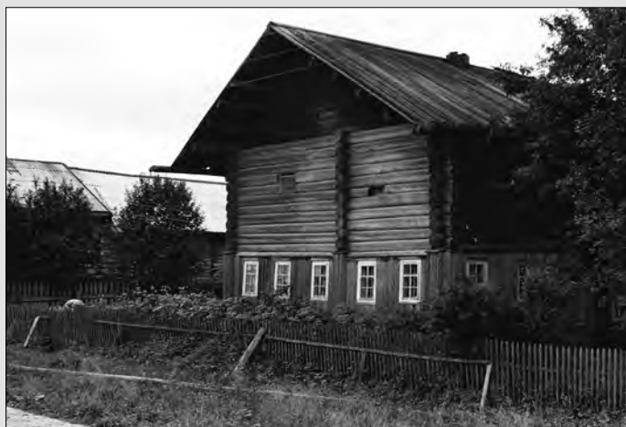
69. Дом с жилым первым этажом и поветью над ним (с волоковыми окнами). Деревня Кремлево
