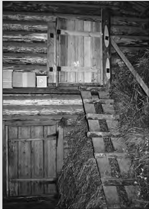
40. Внутренняя хозяйственная часть дома Н. И. Кулякиной: повéть и вход в клéти ( клéтки ), устроенные для хранения запасов и домашней утвари
