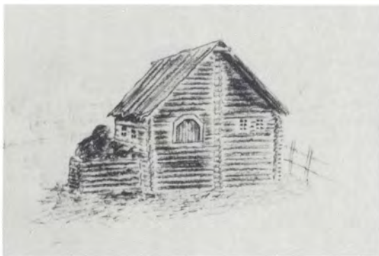
Старая изба с разрушенным взвозом. Дер. Оксина.
