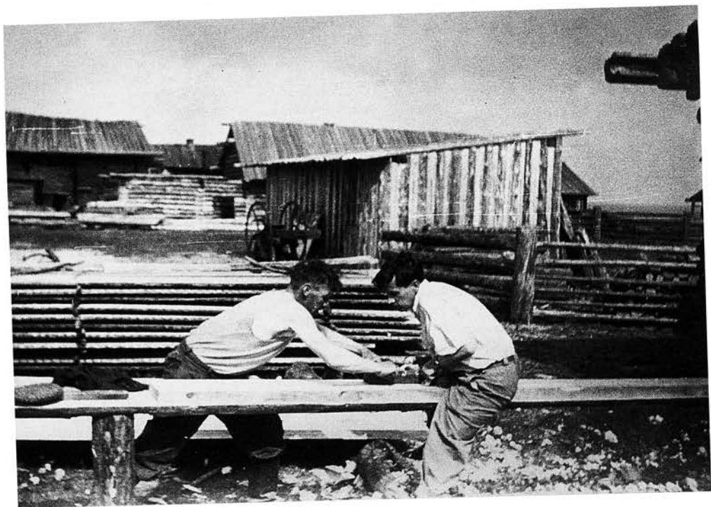
27. На столярных работах, д. Веркола, май—июнь 1959 г.
