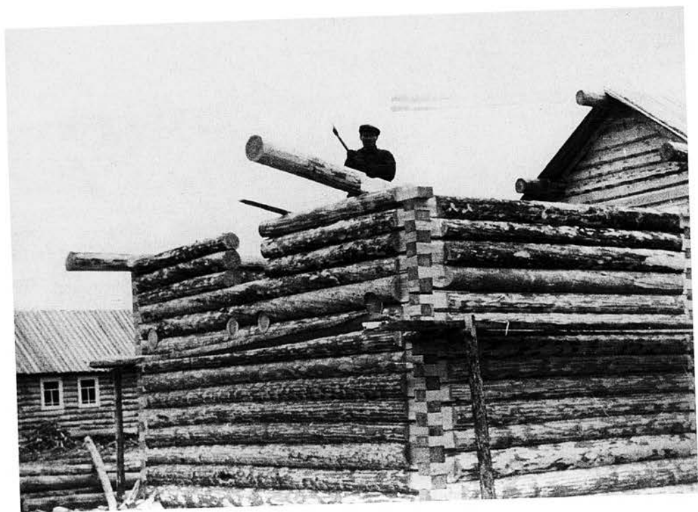
26. Складывание сруба избы, д. Веркола, май—июнь 1959 г.
